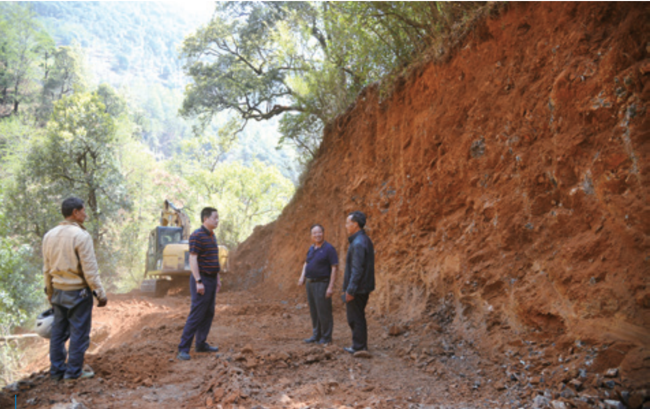
援派盐边县干部在互通村道开挖现场调研施工进度
