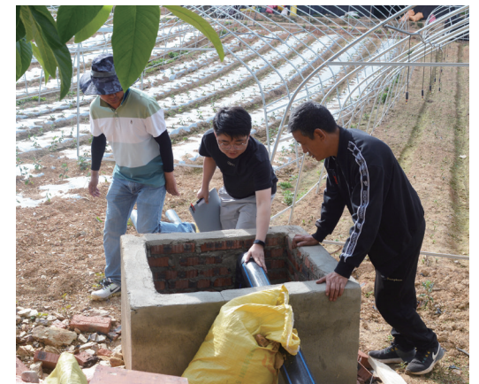
▲攀钢启动援藏帮扶引水工程项目，在木里县簸箕箩村修建储水井
